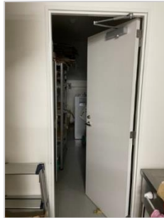
コンプレッサーと作業室の間の扉
